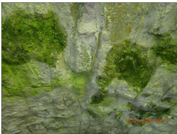
17.Průsak na nosné konstrukci.JPG
