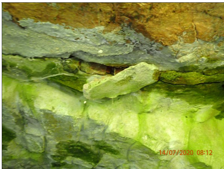
16.Degradace betonu nosné konstrukce.JPG
