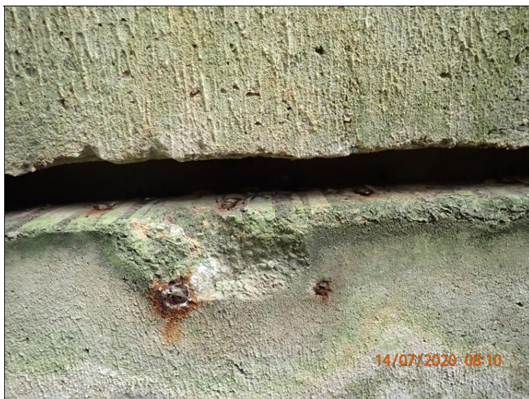
11.Mezera mezi jednotlivými dílci PREFA rámů.JPG
