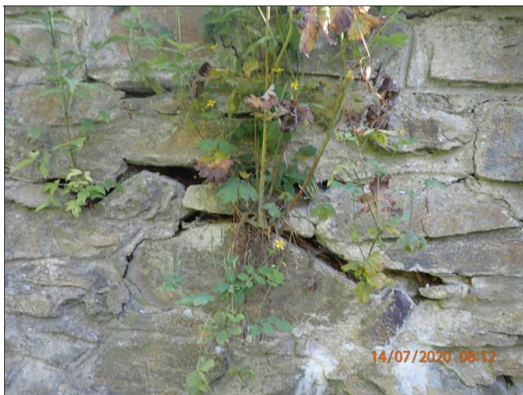
13.Poškozené spárování na čele vpravo.JPG
