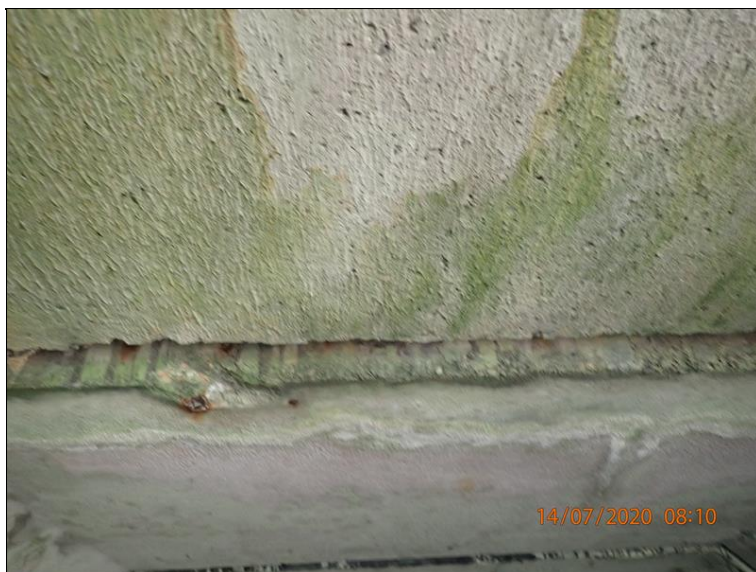
10.Průsak na nosné konstrukci.JPG
