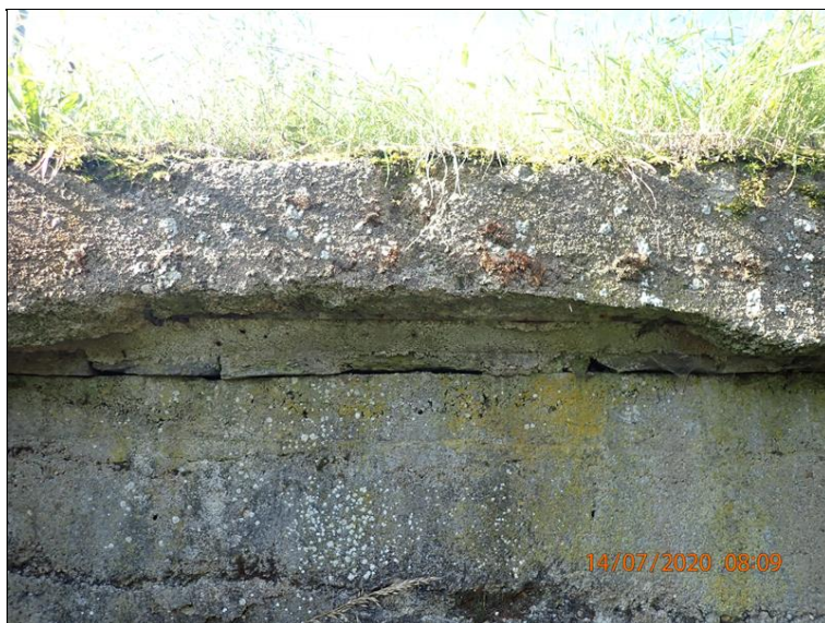
05.Degradace betonu čela a římsy levo.JPG
